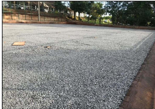
Base de Brita a receber compactação mecânica
