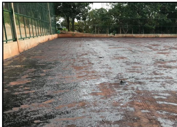
Imprimação da Base Compactada
